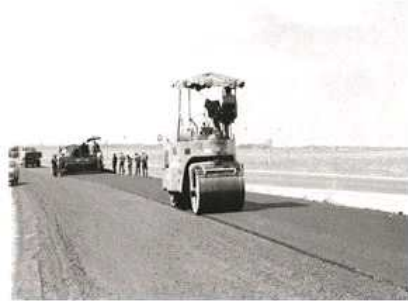
태국 파타니-나라티왓 고속도로 공사
